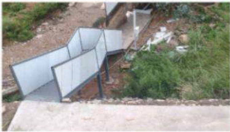
昆粮四库边坡
