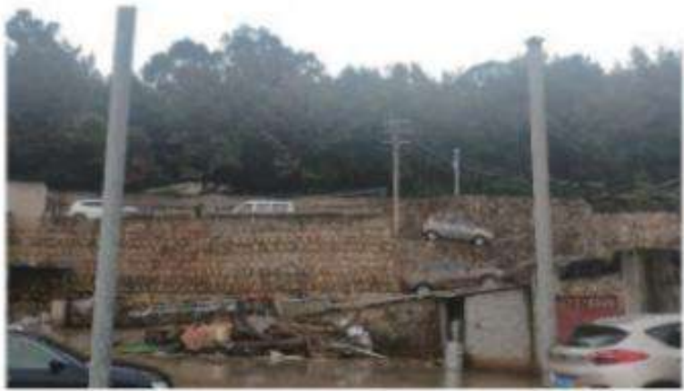
机修厂生活边坡
