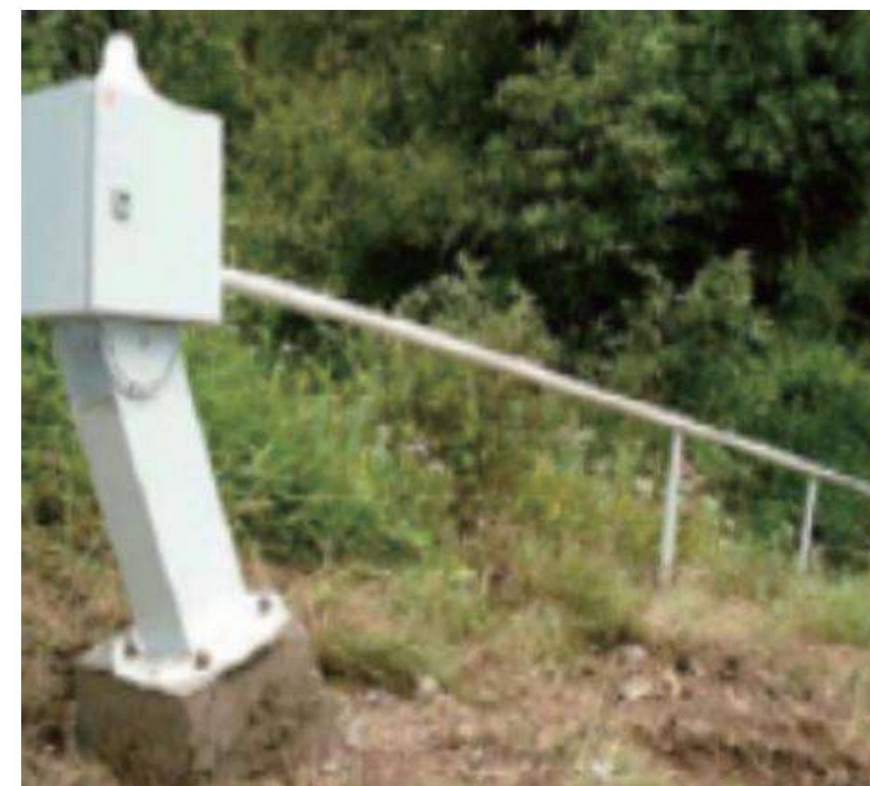
地表裂缝监测
